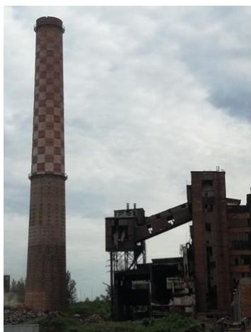
manipulačními plošinami, dvěma bleskosvody, vnějším a vnitřním lezením (2x). Celkový stav komínu nebyl dobrý, zejména v koruně a těsně pod ní (15 m) byl silně popraskán a docházelo k uvolňování cihel. Komínový dřík se v místě destrukčního řezu jevil v pořádku, ale během vrtání vývrtů, kdy docházelo k vyfukování sazí ze sousedního vývrtu bylo zjištěno že je v podstatě celý dřík popraskaný.
